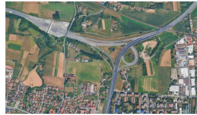
Incroccio autostradale Bruere— W dell'AD
